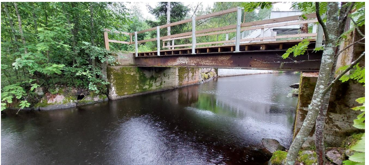
Kuva 6. Vanha työmaatie on jäänyt kävelysillaksi.
