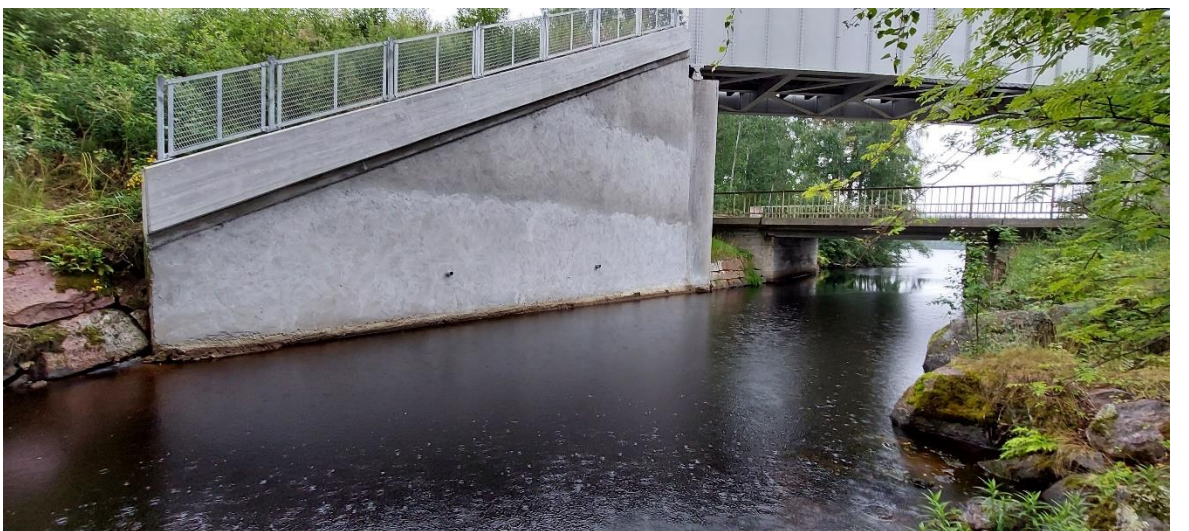
Kuva 7. Junaradan ja maantien siltarakenteita.
